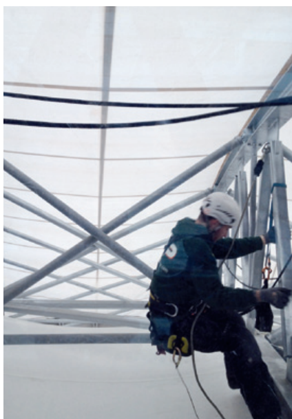
Vista della struttura interna della cupola
